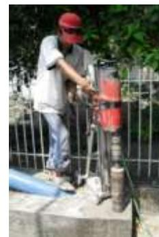
**Gambar 4.** Pengambilan sampel beton
